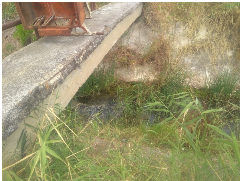
Figura 9. Stato del calcestruzzo di rivestimento in prossimità di una passerella di attraversamento a circa 740 m della paratoia dell'impianto idrovoro del torrente Galaso.
