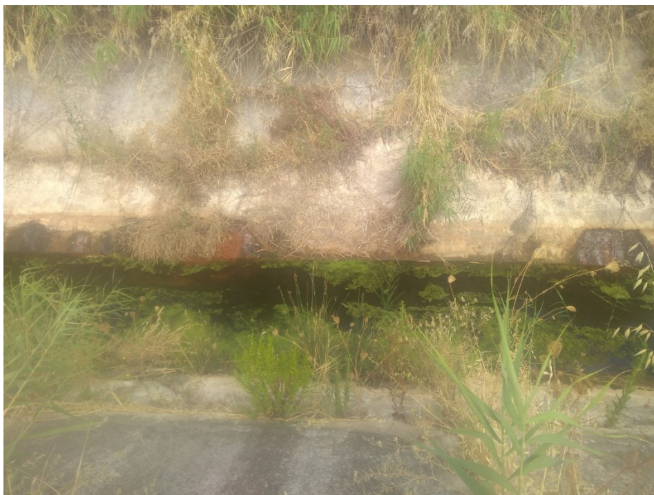
Figura 8. Stato del calcestruzzo di rivestimento in prossimità della paratoia dell'impianto idrovoro del torrente Galaso.
